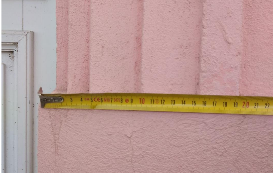
Slika II: Fotografija mjerenja detalja zgrade
