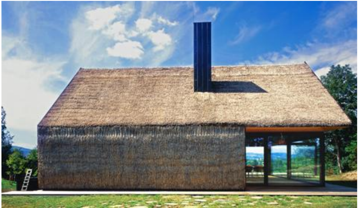
Slika 37. Kuća za odmor „Zagorska hiža“ arhitekt Davor Mateković, Kumrovec
