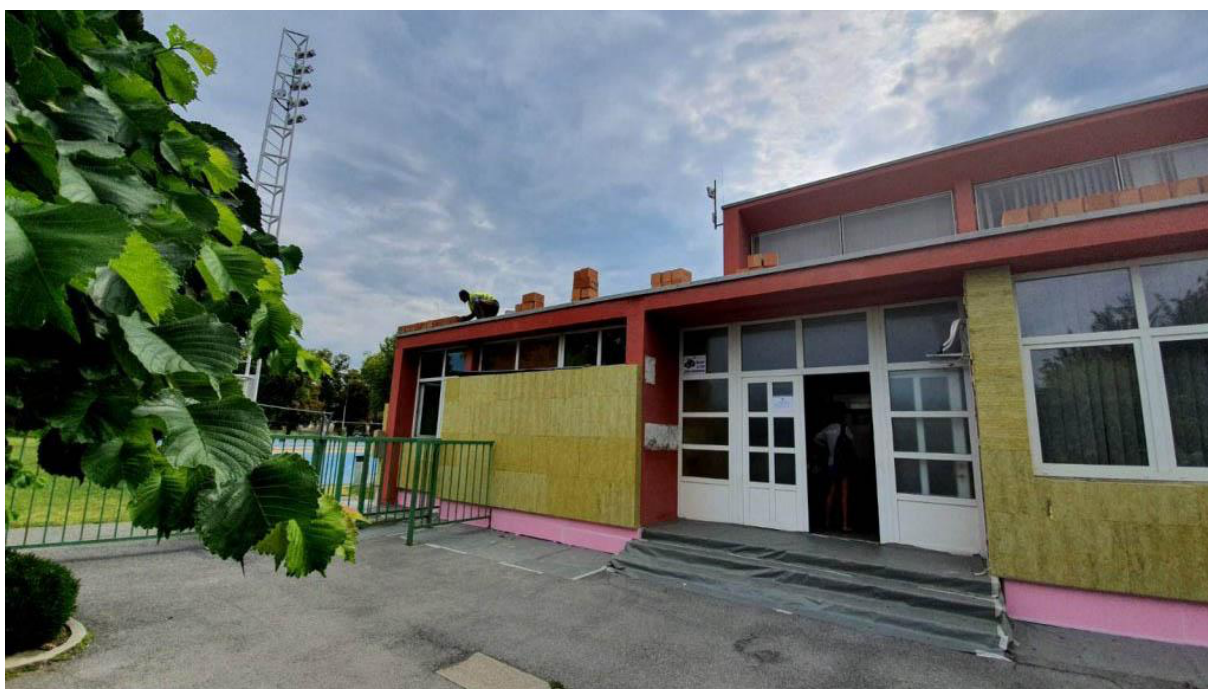
Slika 35. Zgrada srednjoškolskog igrališta u Osijeku, prikaz radova na krovu objekta
