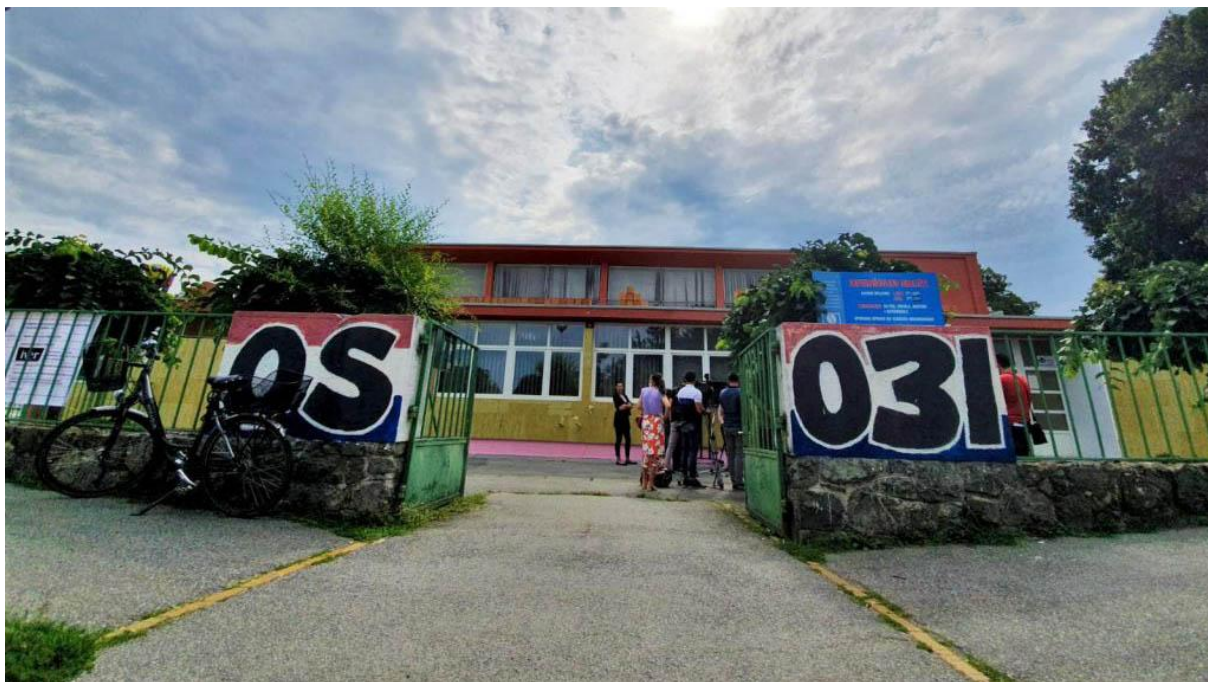
Slika 34. Zgrada srednjoškolskog igrališta u Osijeku
