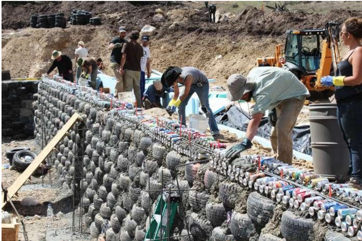
Slika 28. Primjer načina gradnje i konstrukcije Earthship kuće
