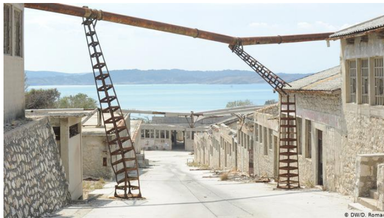
Slika 8. Devastirane instalacije na Golom otoku
