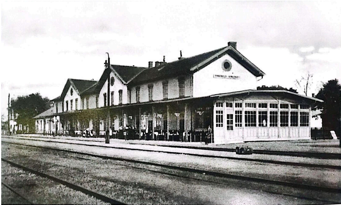
Slika 2. Željeznički kolodvor Vinkovci (Izvor: Grgurovac, 2012.)
