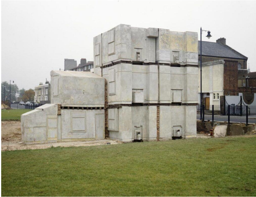
Slika 6. Rachel Whiteread, Kuća, beton, 1993.
