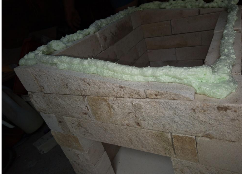
Slika 21. Gradnja kućice od cigle, cigla i poliuretanska pjena, 2023.
