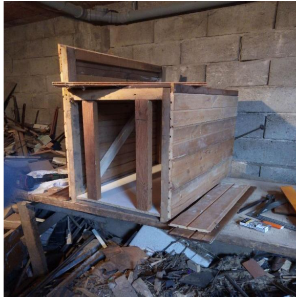
Slika 18. Oblaganje konstrukcije drvenim daskama, 2023.
