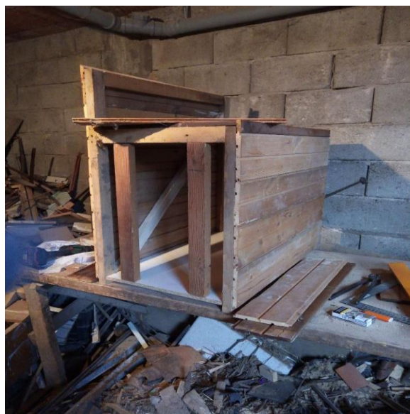
Slika 18. Oblaganje konstrukcije drvenim daskama, 2023.
