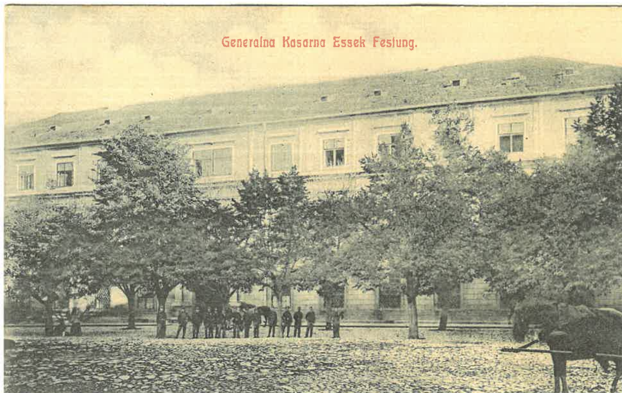
Slika 1. Zgrada kasarne, pogled sa stražnje strane
