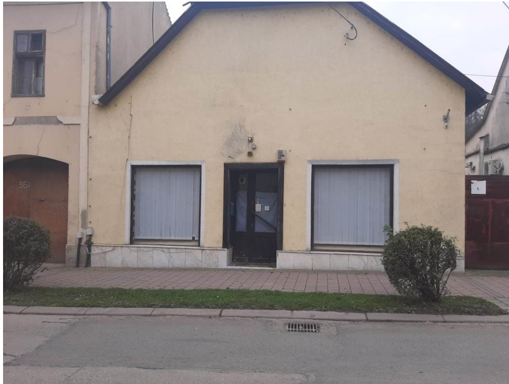
Fotografija 8. Zgrada 5 (privatna zbirka) - Trgovina, prodavaonica mješovite robe/diskont pića/ prodavaonica kućanskih uređaja
