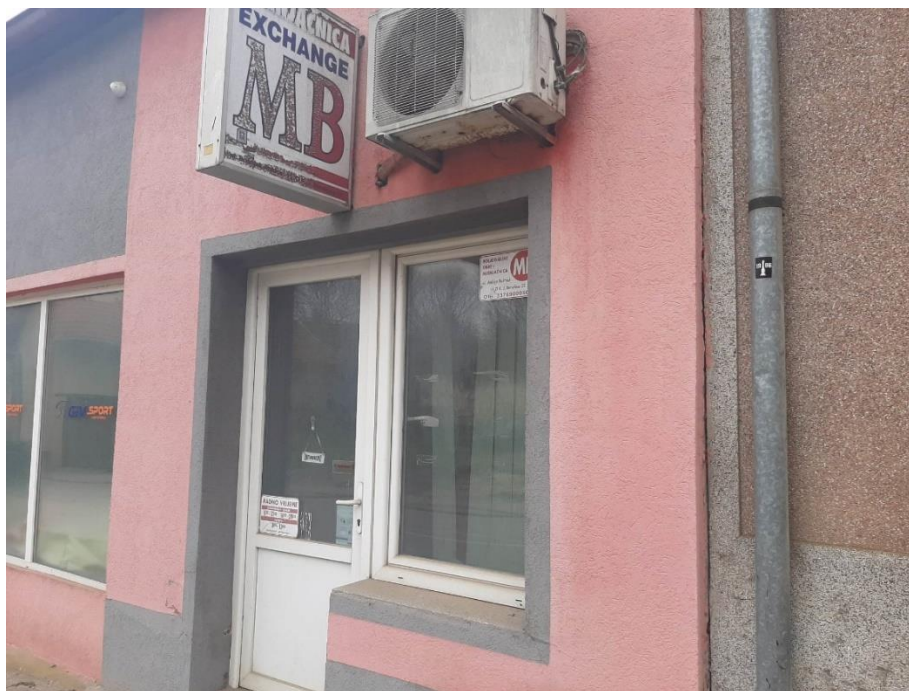
Fotografija 34. Zgrada 21(privatna zbirka) - Foto-studio, butik „Una“/ mjenjačnica
