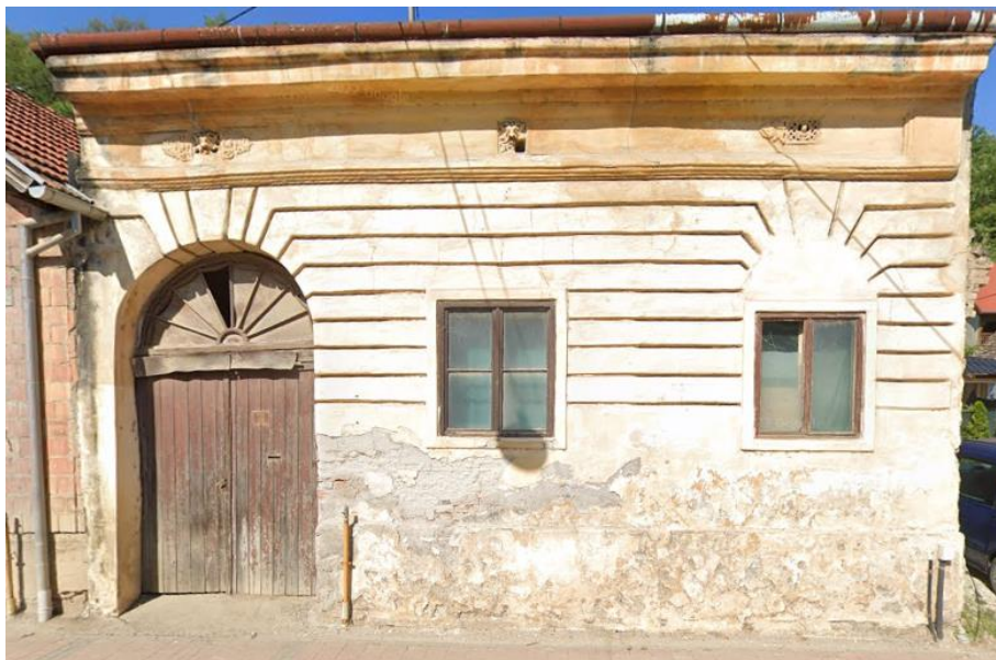
Fotografija 32. Zgrada 20 (privatna zbirka) – Zlatarska i urarska radnja
