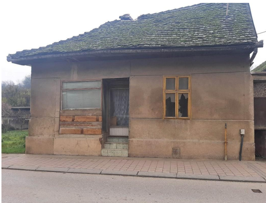
Fotografija 14. Zgrada 9 (privatna zbirka)- Brijački i frizerski salon/ Slastičarna „Trenc“
