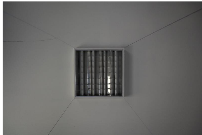
Prilog 36. "nevidljivi" stup lijevog dijela prostora Tijela slike
