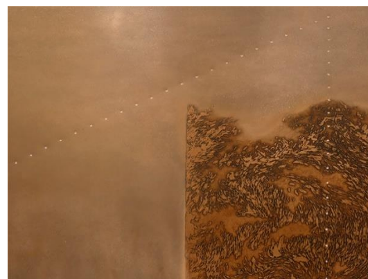
Slika 51. Detalj rada Pogled na staro mjesto nakon intervencije bušilicom po ploči
