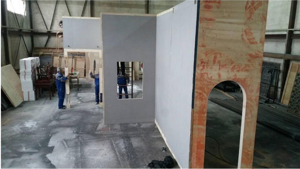
Slika 31. Montaža kulisa u radionici
