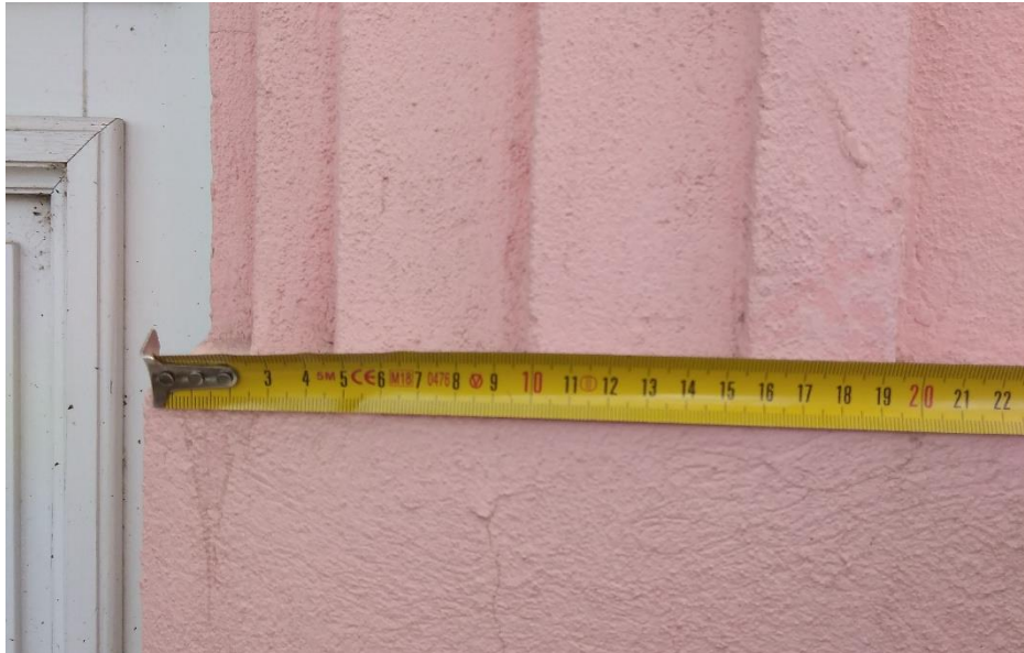
Slika II: Fotografija mjerenja detalja zgrade
