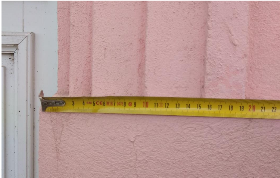
Slika II: Fotografija mjerenja detalja zgrade
