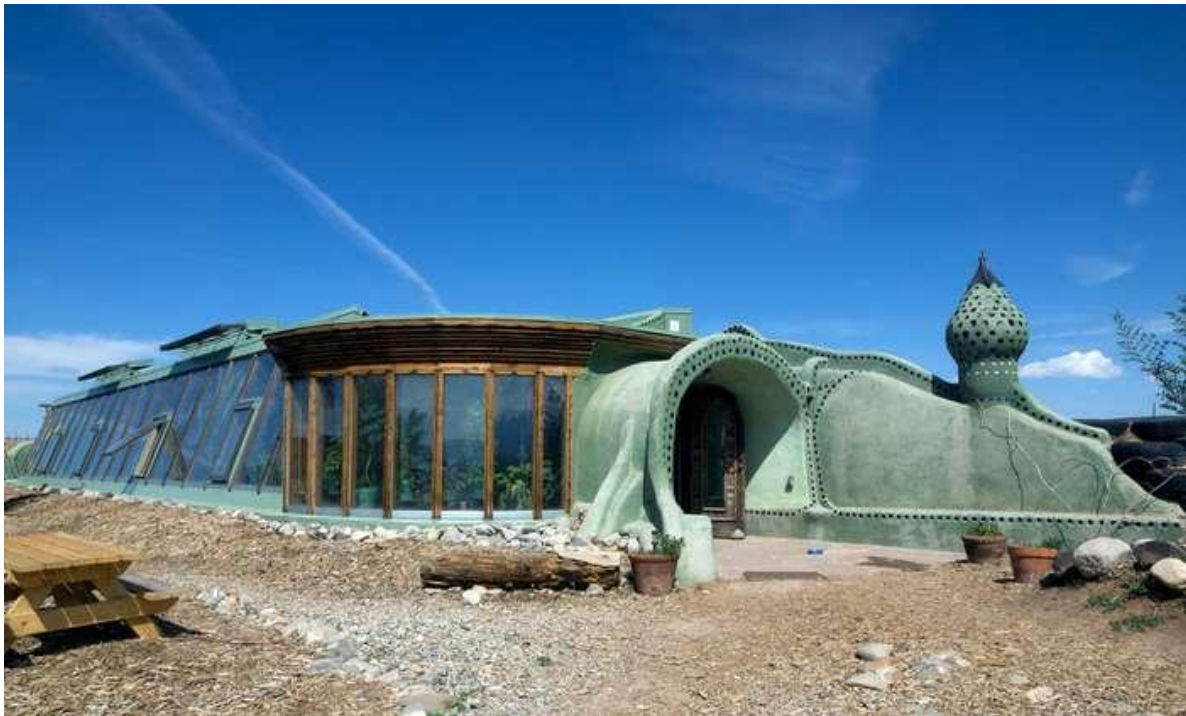
Slika 27. Primjer Earthship kuće, začetnik i arhitekt koncepta, Michael Reynolds, Meksiko
