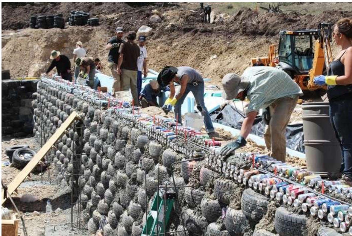
Slika 28. Primjer načina gradnje i konstrukcije Earthship kuće
