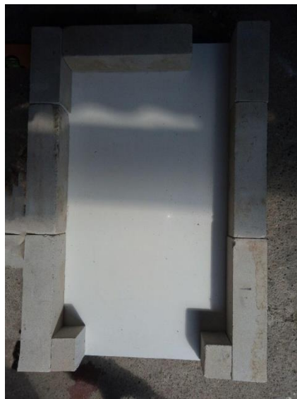
Slika 20. Gradnja kućice od cigle, cigla i poliuretanska pjena, 2023.
