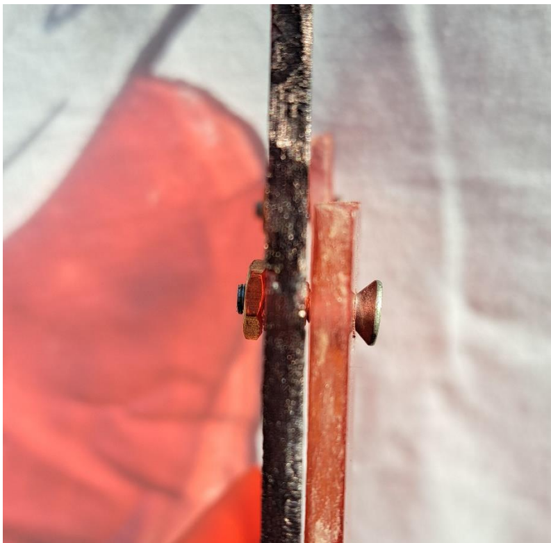
Slika 16. Krupni prikaz spoja ruke s trupom iz profila
