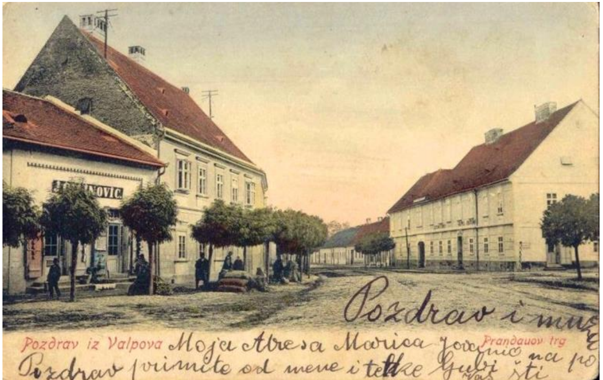
Slika 1. Stara razglednica Grada Valpova Izvor: https://tz.valpovo.hr/o-gradu/ , [pristup: 5. 8. 2023.]
