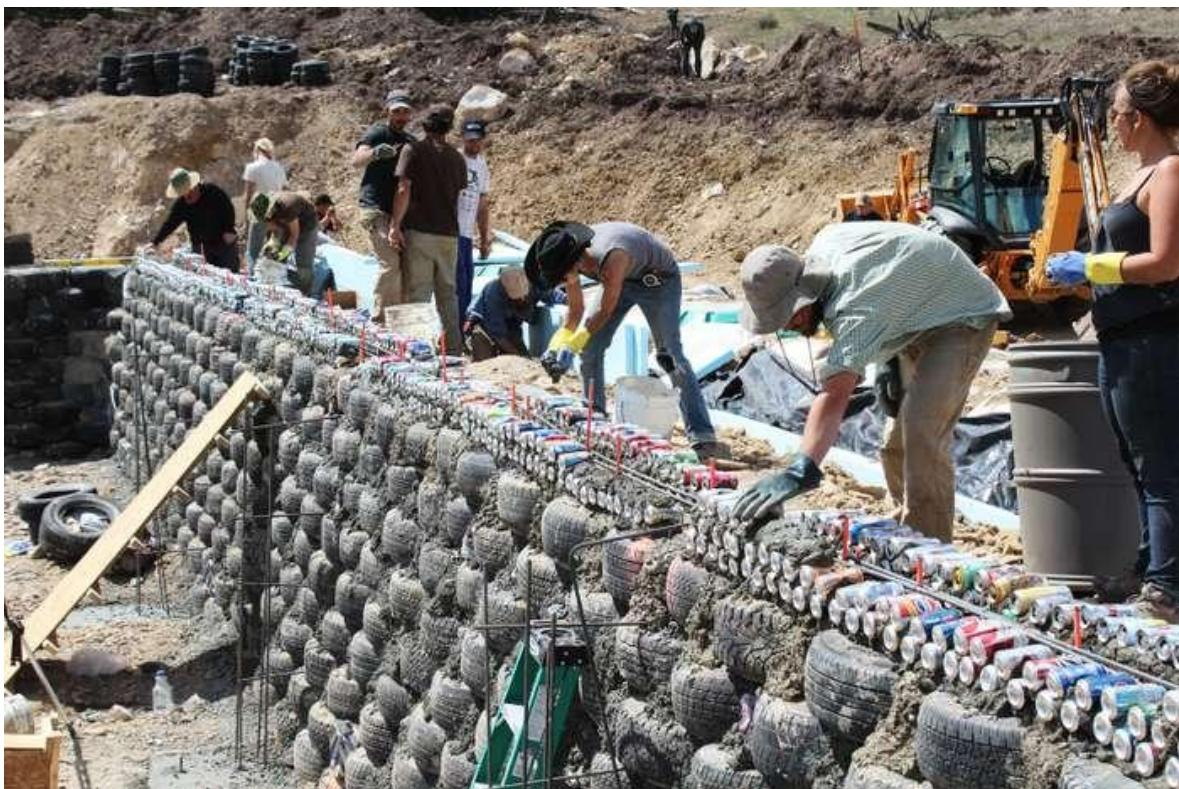
Slika 28. Primjer načina gradnje i konstrukcije Earthship kuće
