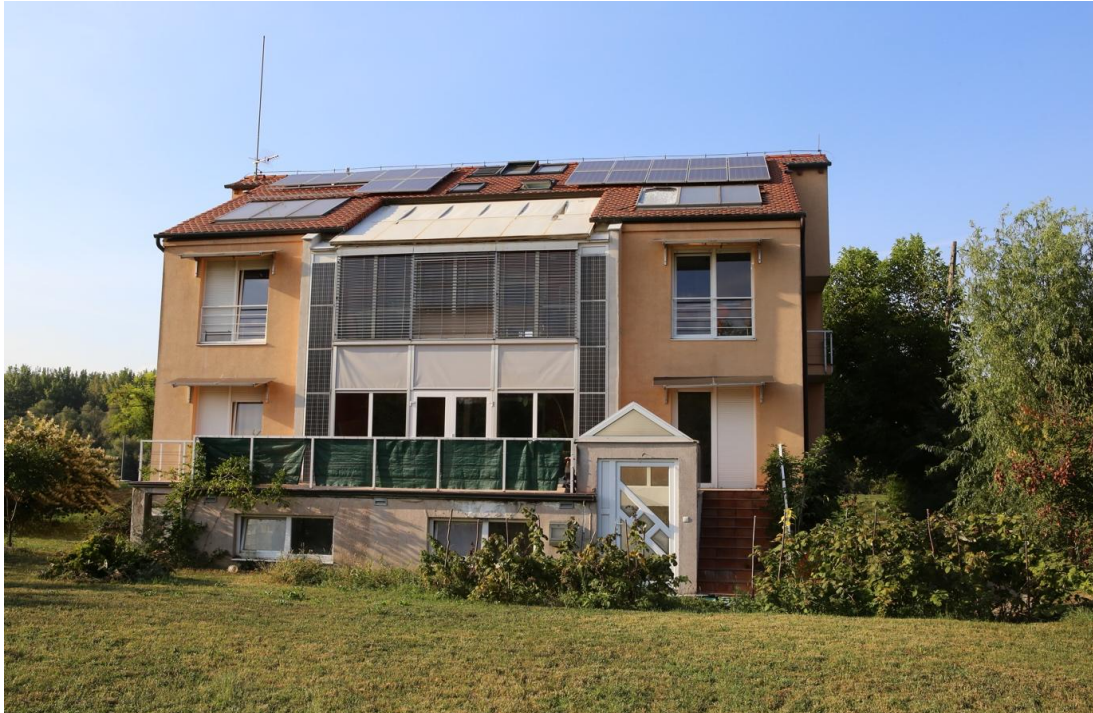
Slika 31. Pasivno-solarna kuća u Osijeku, južna strana, Izvor: Autor
