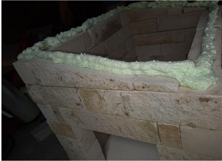
Slika 21. Gradnja kućice od cigle, cigla i poliuretanska pjena, 2023.
