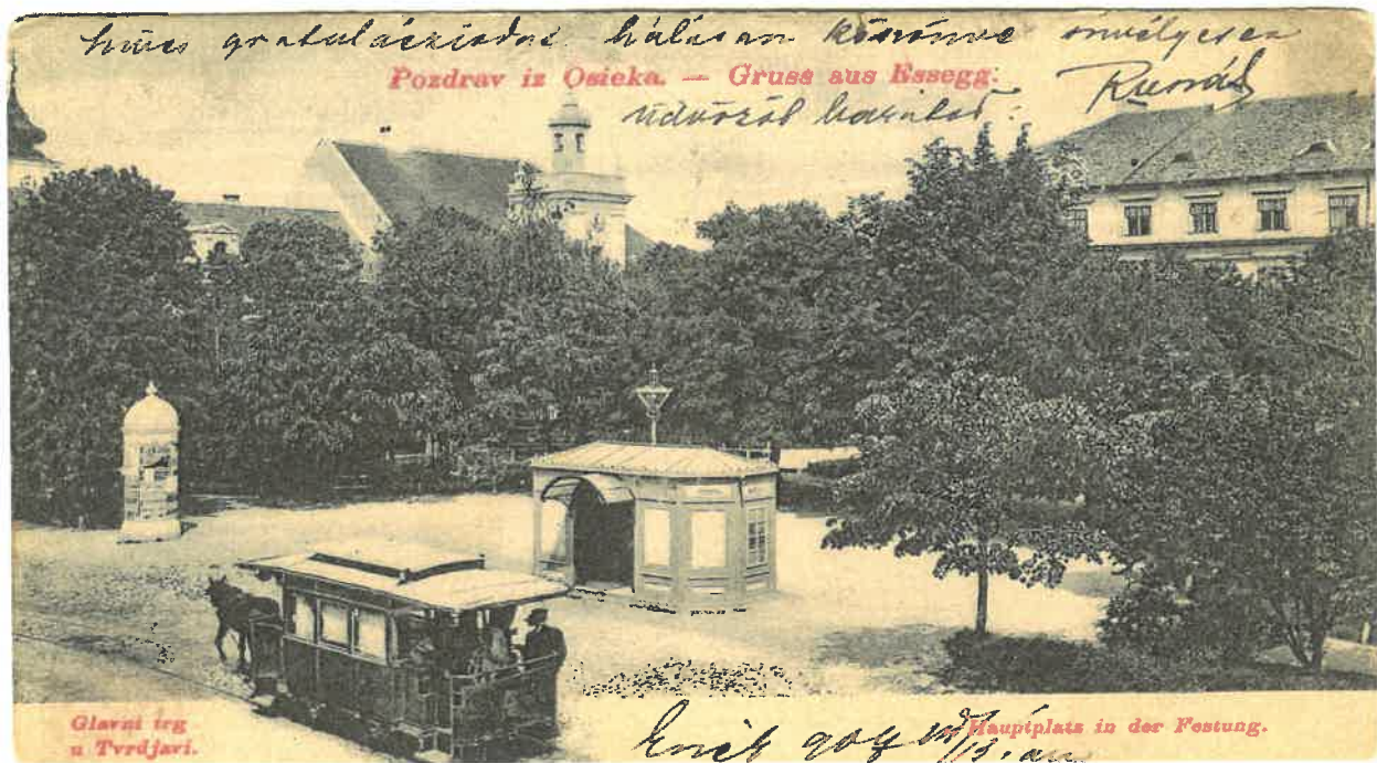
Slika 9. Tramvajska stanica na Glavnom trgu u Tvrđi
