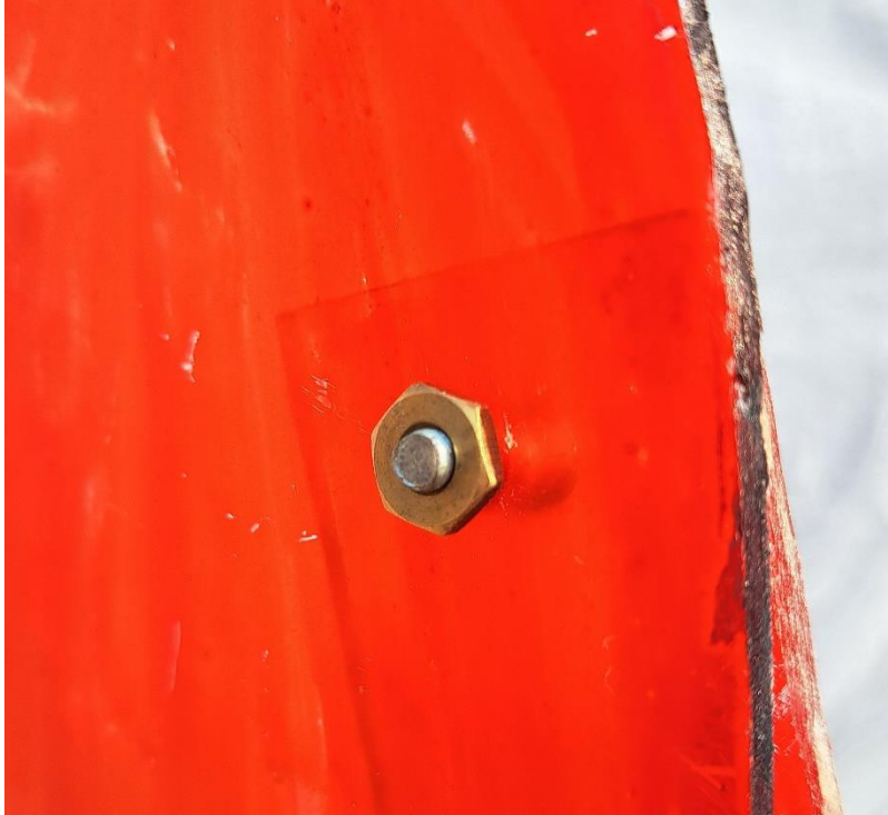
Slika 15. Krupni prikaz spoja ruke s trupom sa stražnje strane
