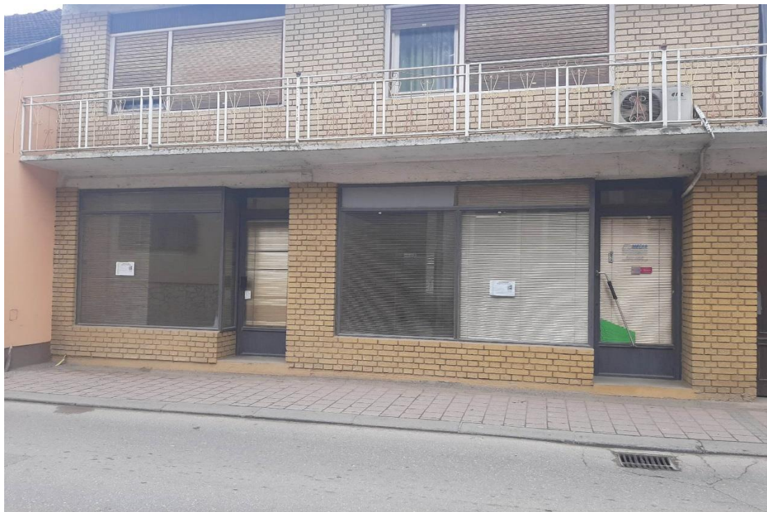
Fotografija 28. Zgrada 18 (privatna zbirka) - Krojačnica/mjenjačnica/butik/ T-com
