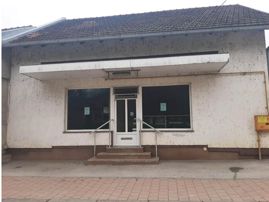
Fotografija 13. Zgrada 8 (privatna zbirka) - Slovačka banka/ trgovina računalne opreme/ pekara
