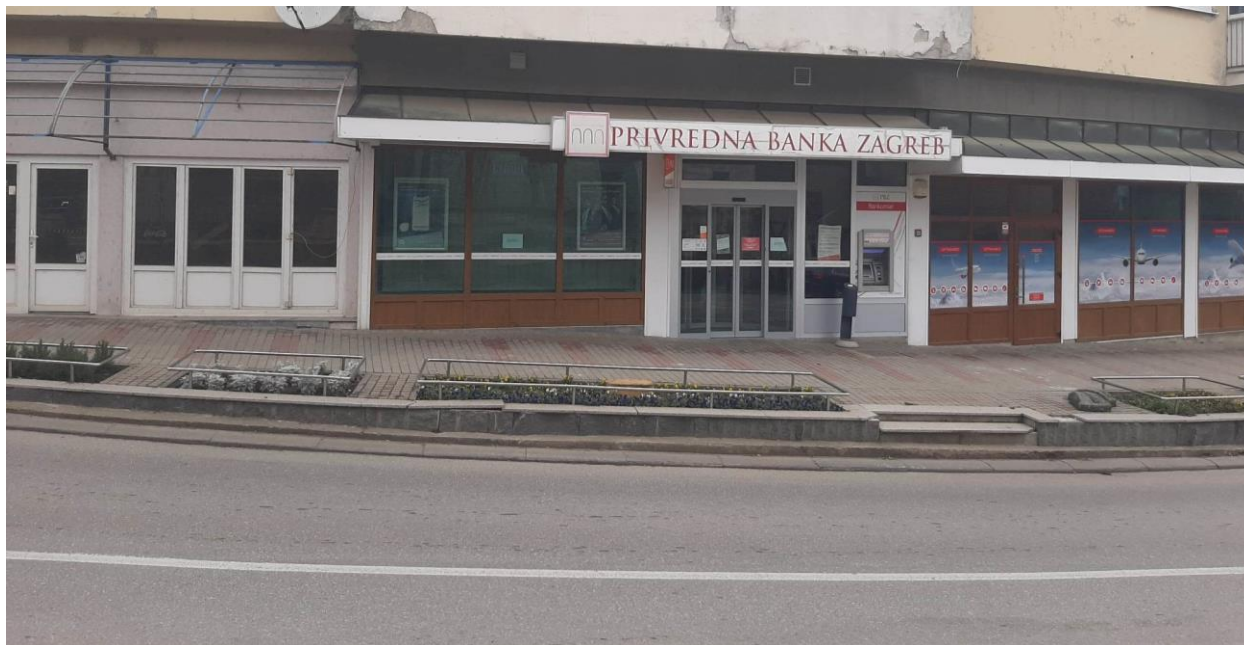
Fotografija 41. Zgrada 25 (privatna zbirka)– Banka/ samoposluga/ trgovina odjeće
